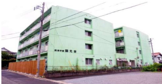
© 朝日新聞社 部員たちが生活していた立正大 大湊南高のサッカー部の寮
